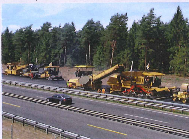
Bild 5: Einbau einer Kompakten Asphaltbefestigung mit dem InLine Pave in einer Breite von 8,50 m, untere Schicht 10 cm AC 22 B S mit Polymermodifiziertem Bitumen 25/55-55 A und obere Schicht 2 cm SMA 8 S mit Polymermodifiziertem Bitumen 25/55-55 A
