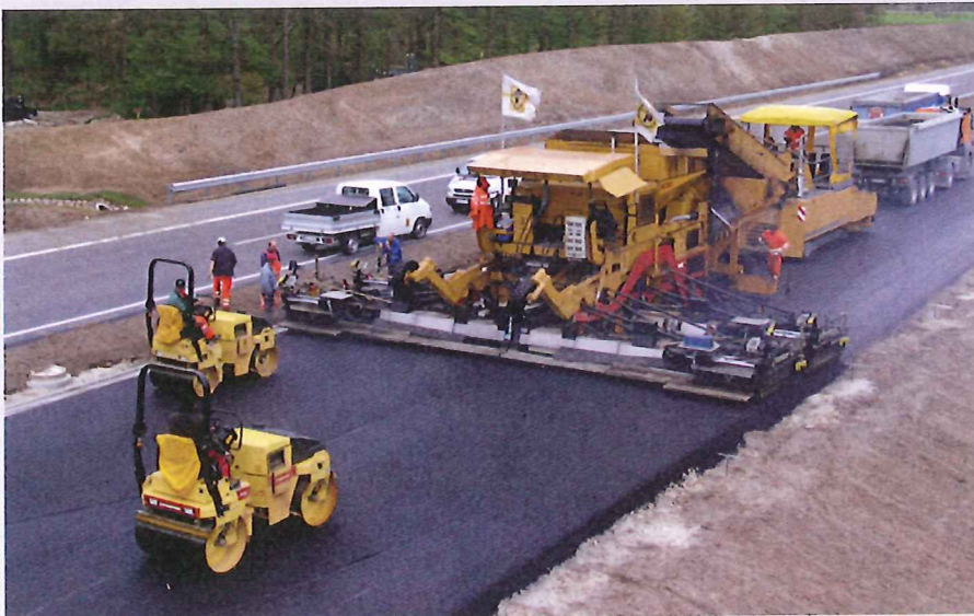
Bild 4: Einbau einer Kompakten Asphaltbefestigung mit dem Kompaktmodulfertiger in einer Breite von 11,50 m, untere Schicht 10 cm AC 22 B S mit Polymermodifiziertem Bitumen 25/55-55 A und obere Schicht 2 cm SMA 8 S mit Polymermodifiziertem Bitumen 25/55-55 A
