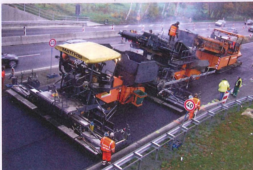
Bild 5: Einbau einer Kompakten Asphaltbefestigung mit dem InLine Pave in einer Breite von 8,50 m, untere Schicht 10 cm AC 22 B S mit Polymermodifiziertem Bitumen 25/55-55 A und obere Schicht 2 cm SMA 8 S mit Polymermodifiziertem Bitumen 25/55-55 A
