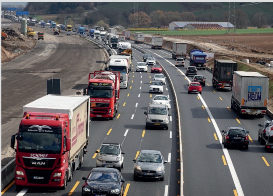
Bild 5: Auch der Einfluss von baustellenbedingten Verkehrsführungen kann mit der rechnerischen Dimensionierung berücksichtigt werden (hier: 6+0-Verkehrsführung mit eingeschränkten Breiten der Fahrstreifen)
