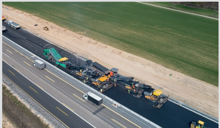
Bild 6: Einbau einer kompakten Asphaltbefestigung im gestaffelten Einbau auf einer BAB
