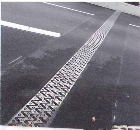
Bild 2: Gestaltung der Übergangskonstruktion zwischen Straße und Brückenbauwerk mit einem Streifen aus Gussasphalt
