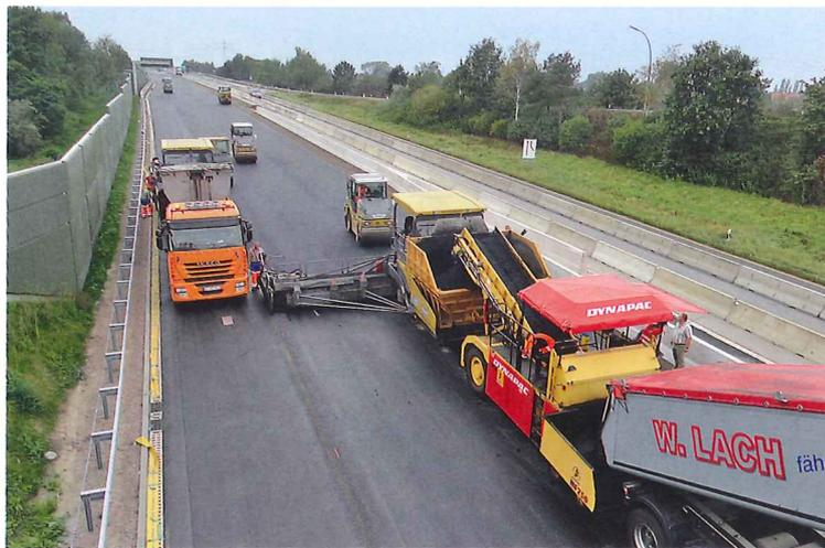
Bild 1: Einbau von Offenporigem Asphalt
