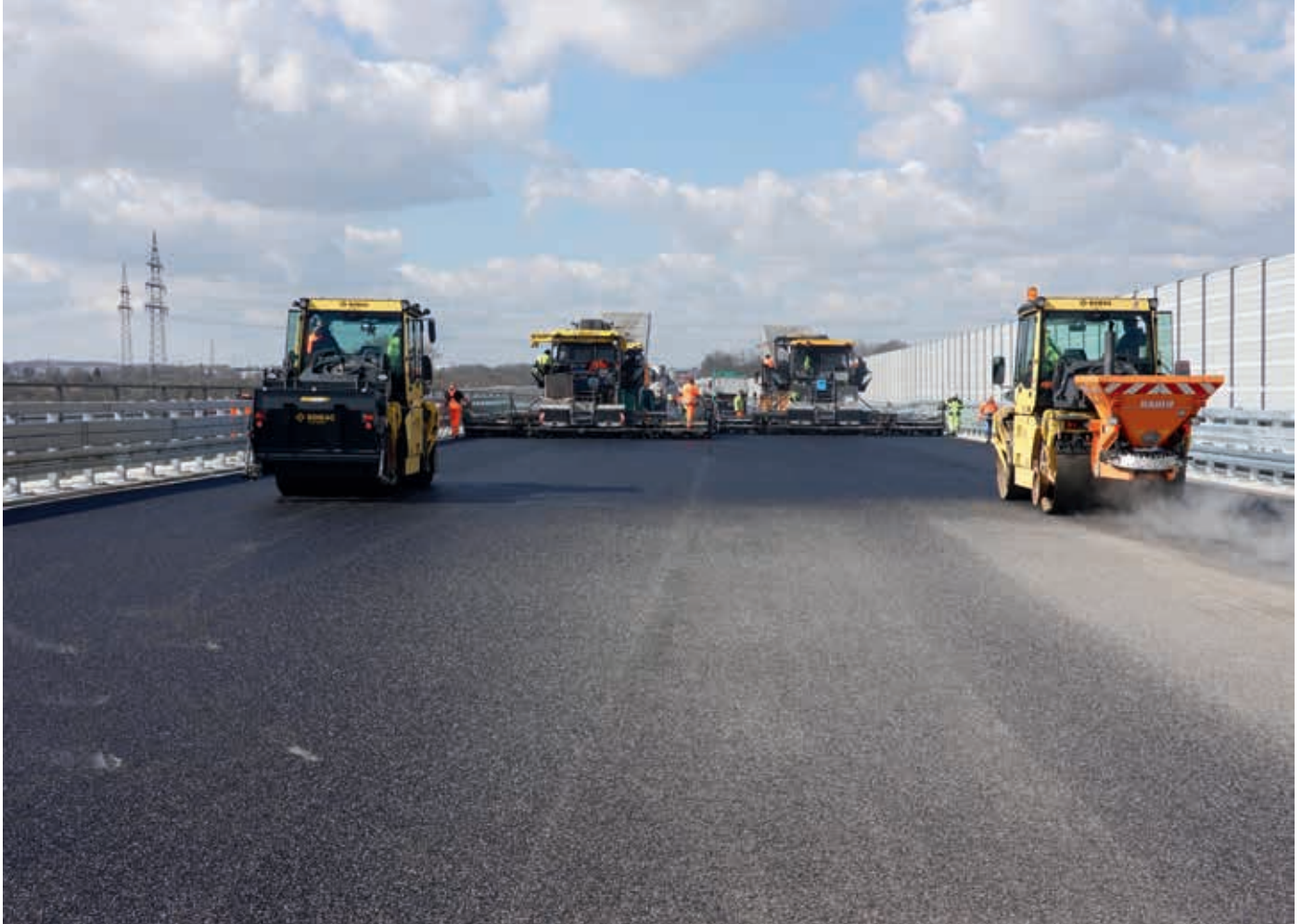
Bild 1: Einbau einer Asphaltdeckschicht aus einem Splittmastixasphalt mit einem viskositätsveränderten Polymermodifizierten Bitumen auf einem Brückenbauwerk. (Quelle: Schäfer Consult)
