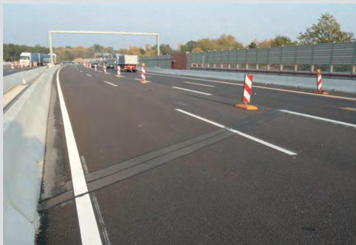
Bild 5: Ausführung einer OPA auf einem Brückenbauwerk mit einem Gussasphaltstreifen am Fahrbahnübergang und an der Randeinfassung
